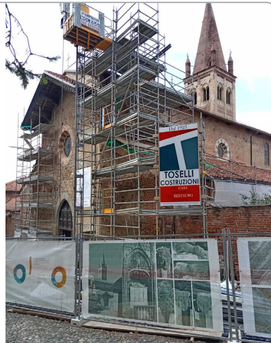
Saluzzo – Consolidamento statico Chiesa San Giovanni
